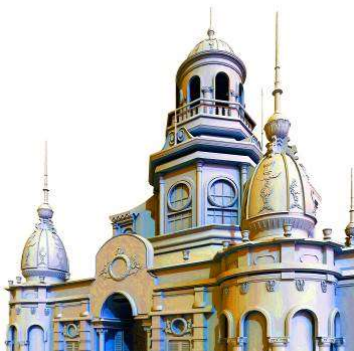
نموذج رقم (٦) لنتائج استخدام الرفع المساحي والفوتوجراممري للواجهة الامامية لقصر السكاكيني
