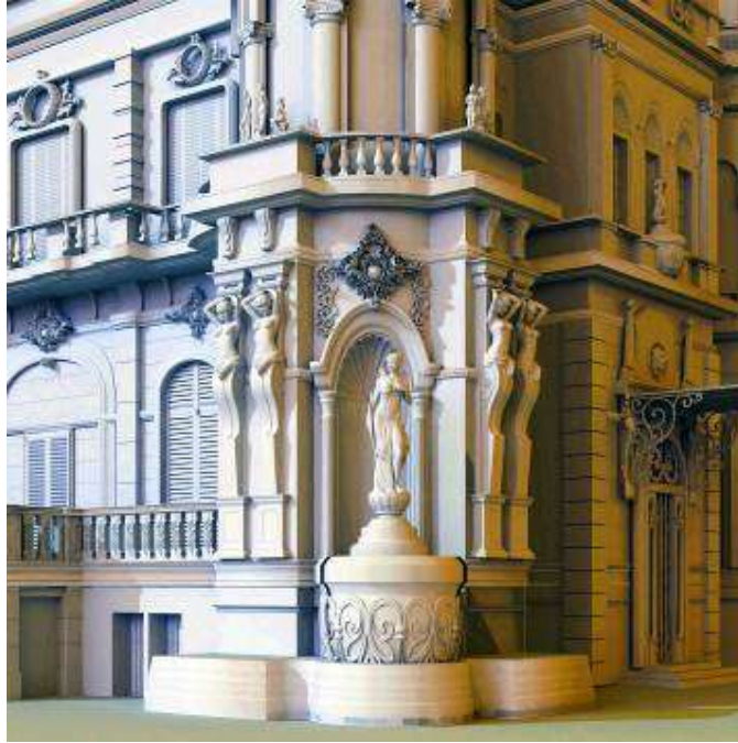
نموذج رقم (٨) لنتائج استخدام الرفع المساحي والفتوجراممري للزخارف المحيطة بالقصر بشكل ثلاثي الأبعاد
