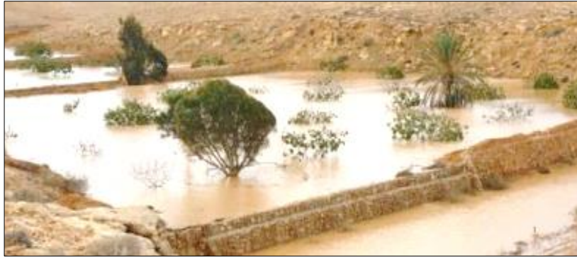
صورة (٢) أحد نماذج سدود تثبيت التربة الزراعية بمجاري الأودية بمنطقة الدراسة- جنوب المنطقة
