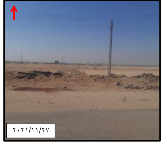
صورة (١) اقتراب الشبكة الكهربائية من منطقة الدراسة
